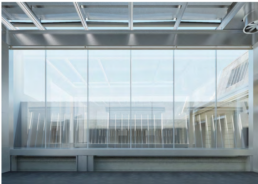
VERRIÈRE : FACE LATÉRALE - INTÉRIEUR GLASS ROOF: LATERAL FACE - INTERIOR
